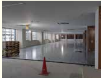
増築棟(2階)の状況 【内部仕上げ工事】
