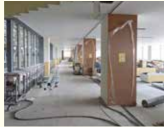
増築棟(4階)の状況 【内部仕上げ工事】
