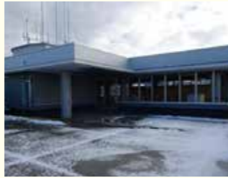
増築棟(屋上)の状況 【市民ホール】
