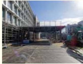
増築棟(屋外)の状況 【正面玄関エントランス(車寄せ)】
