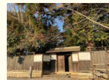
▲旧木俣家屋敷の敷地の外観
