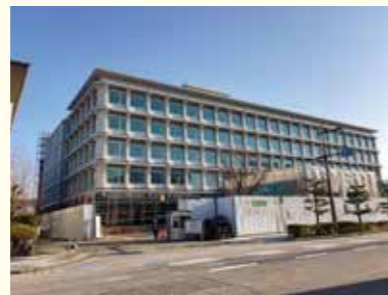
完成間近の新庁舎の外観①
