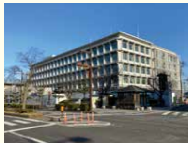
完成間近の新庁舎の外観②
