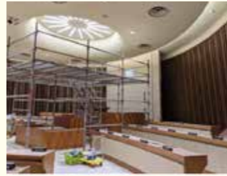
増築棟(5階)の状況 【内部仕上げ工事】
