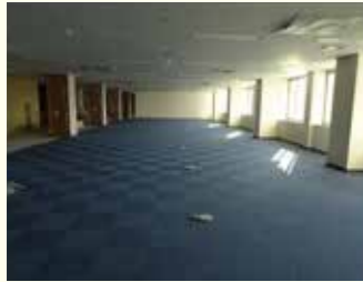
増築棟(2階・執務室)の状況 【内部仕上げ工事】
